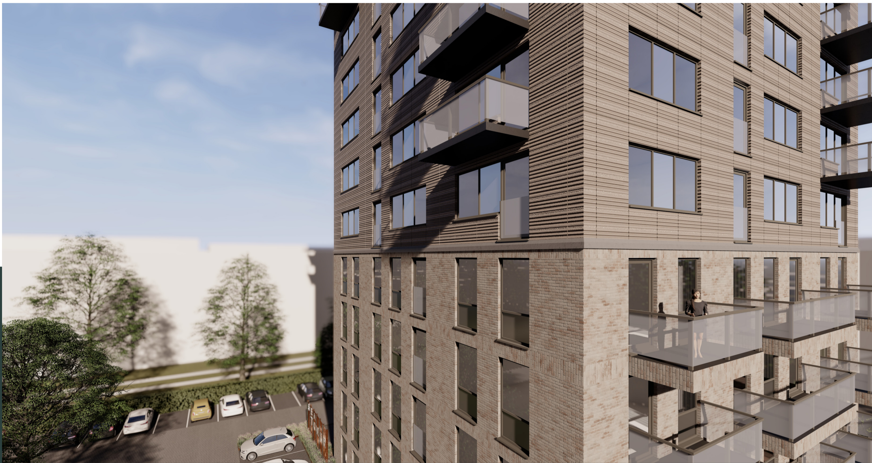
COMBINATIE VAN METSELWERK EN BETON LATTENSTRUCTUUR
