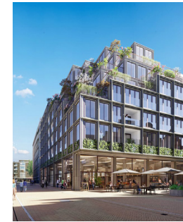
Geen achterkanten aan de openbare ruimte | Mercado, Groningen
