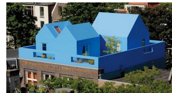
Dakopbouw; Didden-village Rotterdam | MVRDV
