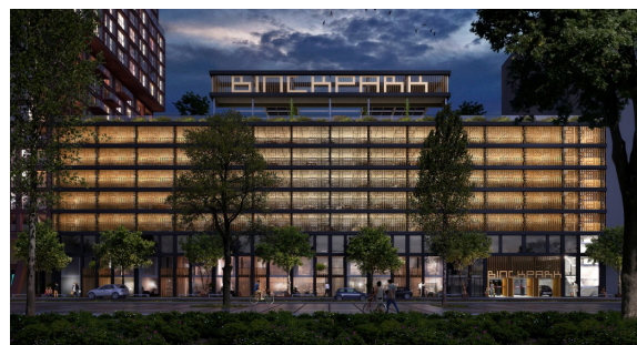
Parkeergarage met publieke plint | Groosman Architecten
