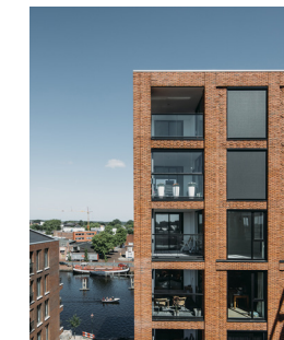
Private buitenruimte op hoogte | De Scheepmaker Housing Complex, Haarlem
