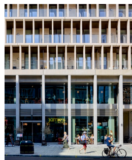
De teruggedegen gevels en arcades verbreden de straat en bieden een buitenruimte onder dak | The Zig Zag gebouw, Londen
