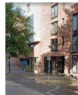
De uitgang van de parkeerplaats geïntegreerd in de gevel | Sem Presserhof, Amsterdam
