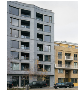
Er is een relatie tussen de straat en de hogere verdiepingen van het gebouw dankzij de loggia's | Cadix, Antwerpen
